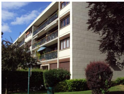
Photo – Façade principale et pignon d'un bâtiment de « type allongé »
